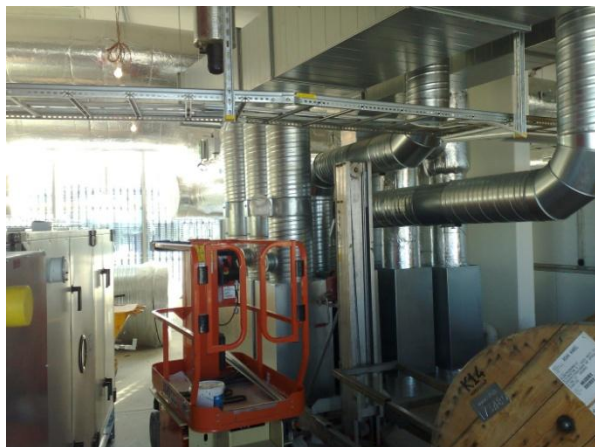
Figur 8.3: Installationer på översta våningen på UMAS.
