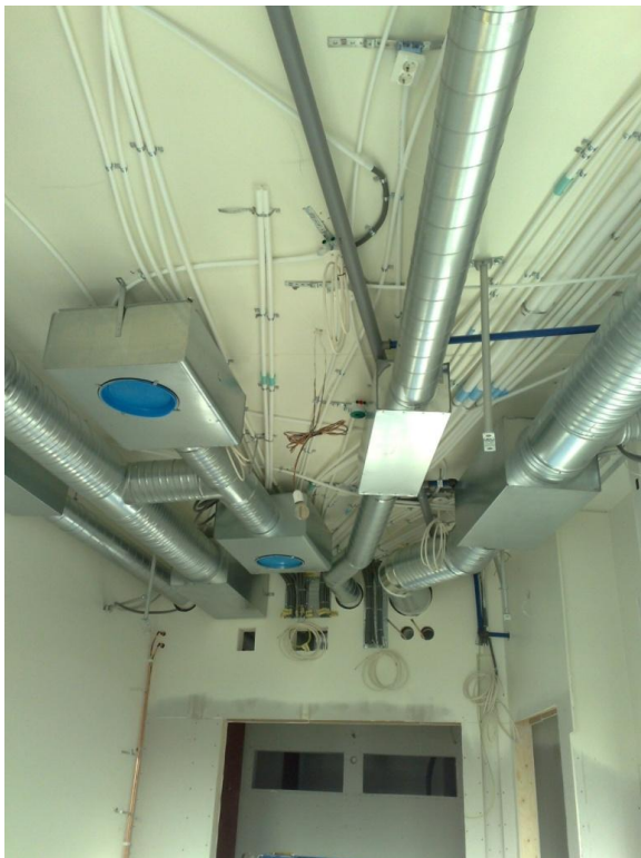
Figur 8.6: Installation i taket i ett renrum.
